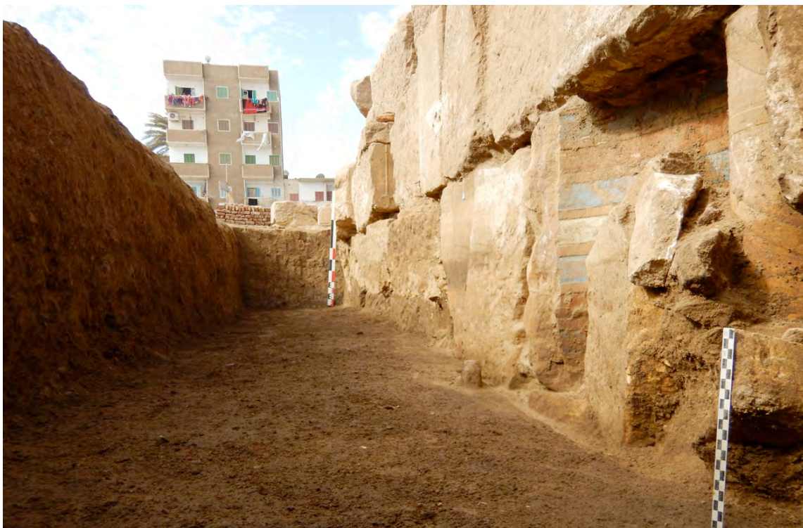
Fig. 9. Tranchée pratiquée le long de la façade du « pronaos ». © CNRS-CFEETK/C. Thiers.
