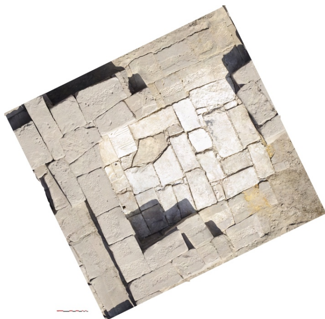
Fig. 3. Orthophotographie du caisson de fondation G2 avec son remplissage de remplois calcaires. © CNRS-CFEETK/P. Mégard.
