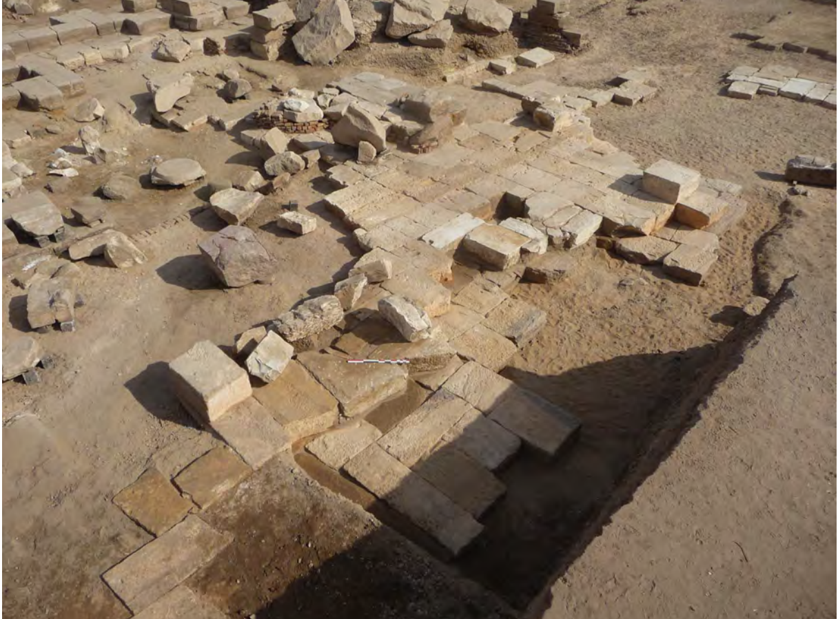
Secteur ouest du naos, murs de grès et remplissage des caissons avec des remplois calcaires du Moyen Empire © CNRS-CFEETK/Chr. Thiers.
