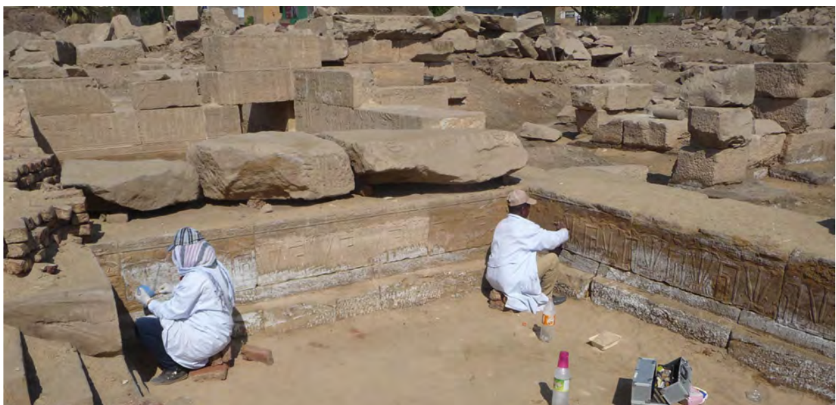
Restauration-conservation des murs de la crypte n° 3 : enlèvement du sel par nettoyage mécanique (scalpel) et compresses de hiba © CNRS-CFEETK/Chr. Thiers.
