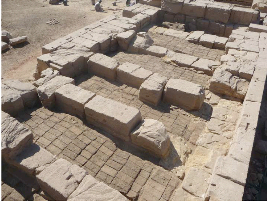
Remplissage de briques crues à l'intérieur des caissons du pylône © Chr. Thiers.
